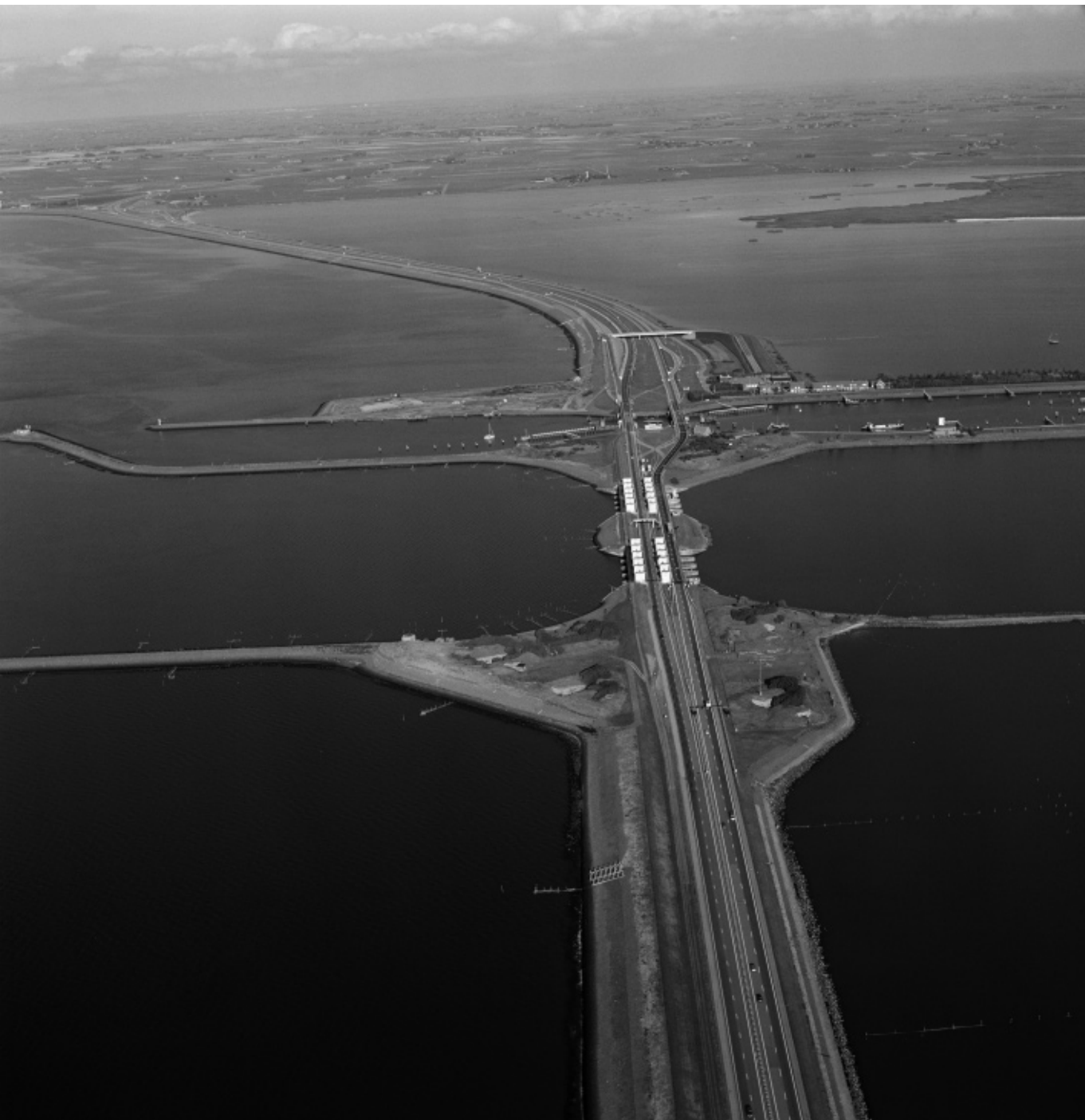
Een luchtbeeld van het sluizencomplex in de Afsluitdijk bij Kornwerderzand, Foto Beeldbank Rijkswaterstaat / Bart van Eyck.
