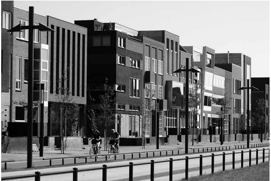
De Lonnekerspoorlaan in Roombeek anno 2010.
