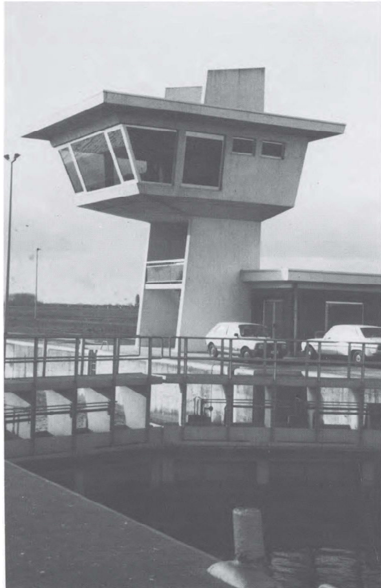
Bovenhoofd van de nieuwe sluis te Komen.
